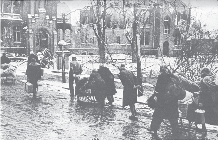
Civili in fuga.
